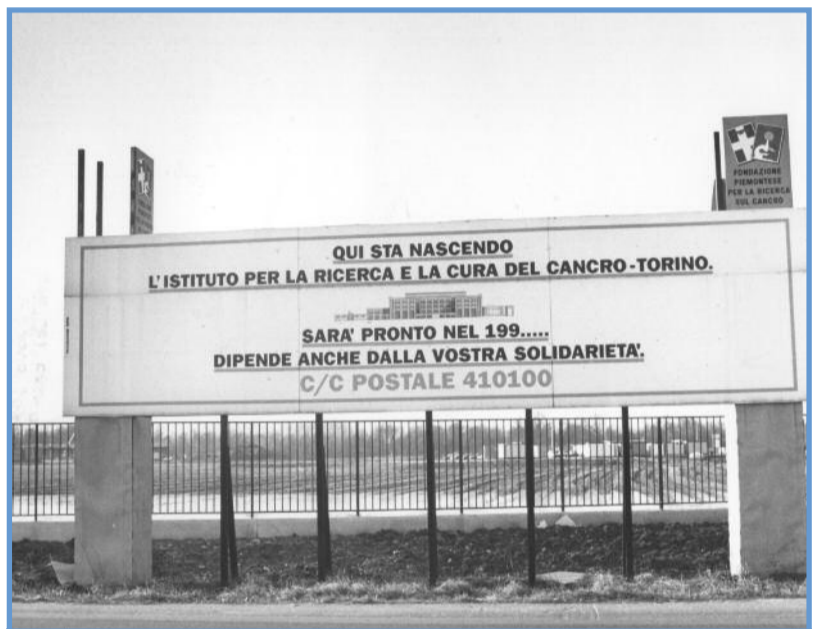
1993 - Il cantiere dell'Istituto di Candiolo
