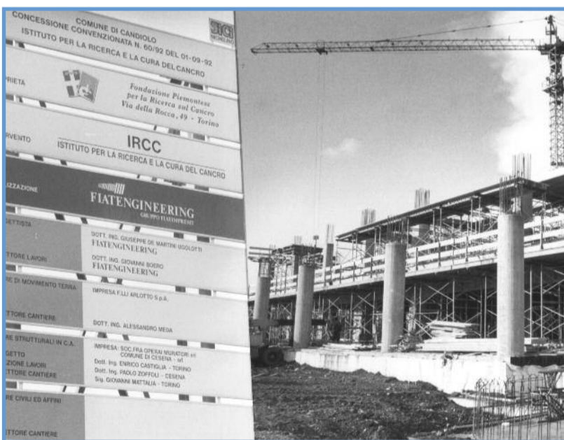
1994 - Avanzamento lavori a Candiolo
