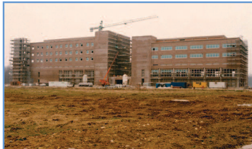
Nella foto: Avanzamento dei lavori - 1995
